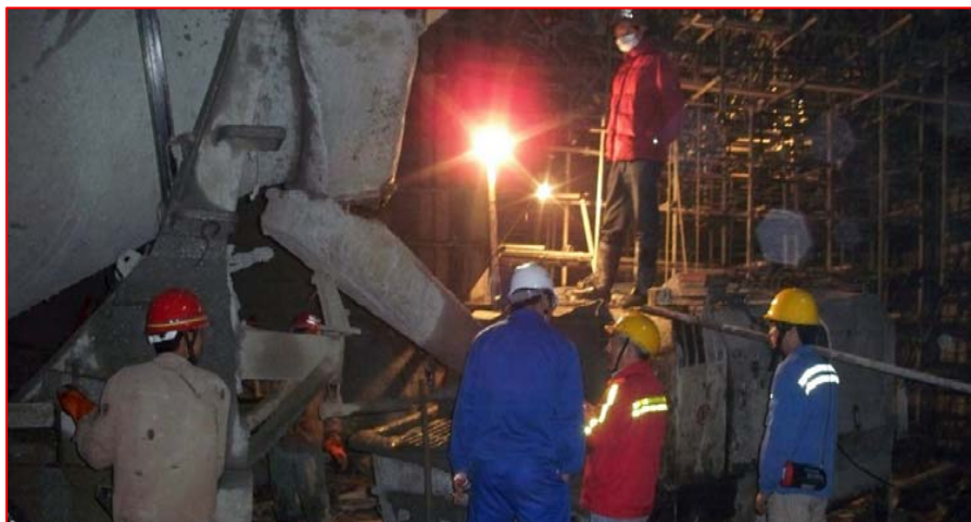
加强混凝土施工过程质量控制
