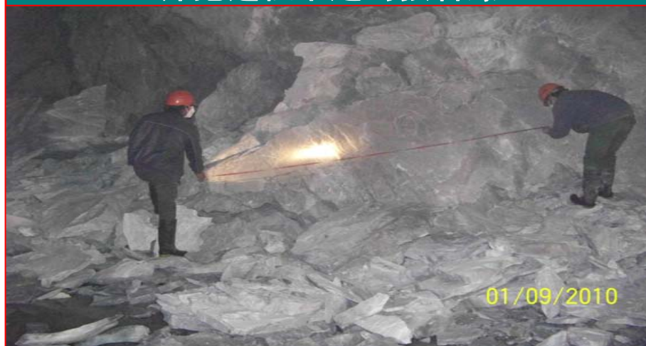
开挖过程中遇到强岩爆
