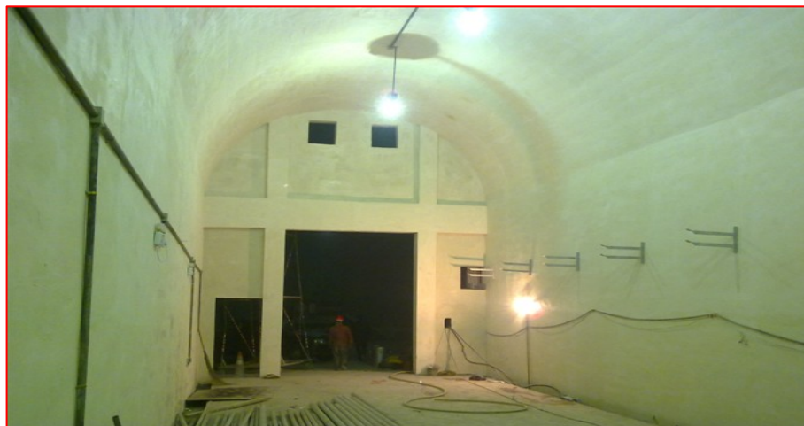
混凝土衬砌单元工程优良率达到85%以上
